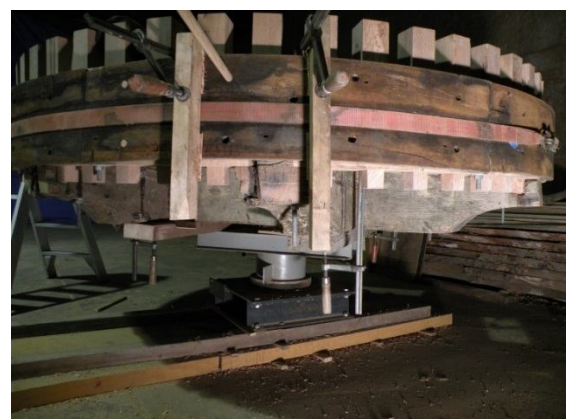
Het herstel van het bovenwiel. Alle kammen zijn vernieuwd.
