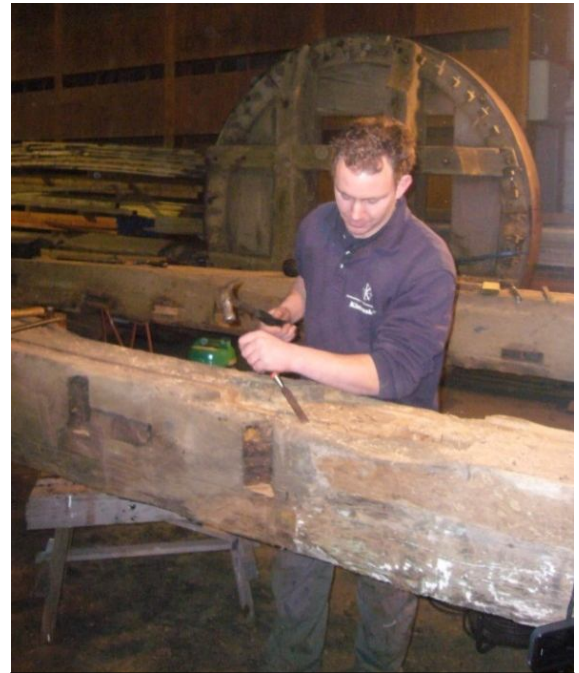
Ron Butterman bezig met de restauratie van de voeghouten.
