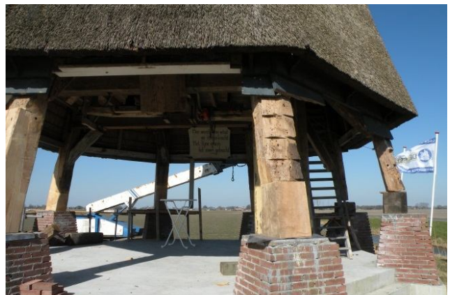
De achtkantstijlen op de nieuw gemetselde poeren.
